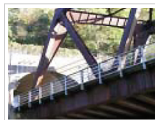
耐侯性鋼材を使用した橋梁
